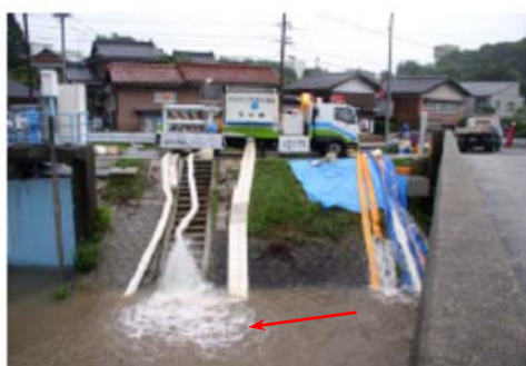
平成 18 年 7 月洪水 排水ポンプ車による排水状況 (小松谷川・米子市青木)
