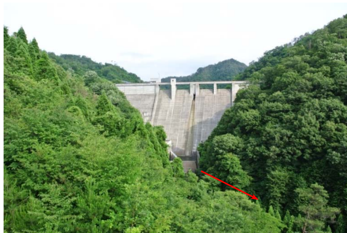
朝鍋ダム 下流側より
