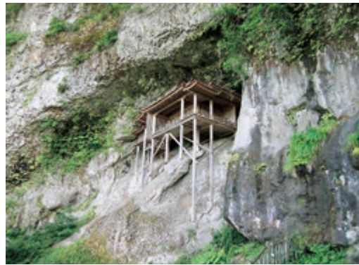
三徳山三仏寺投入堂 미토쿠산 산부쓰지 절 나게이레도 불당
