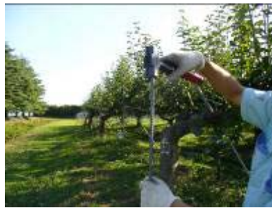
支柱の打ち込み ↑
