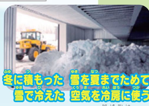
サントリブ ロダクツ株式会社 天然水奥大山ブナの森工場雪室システム
