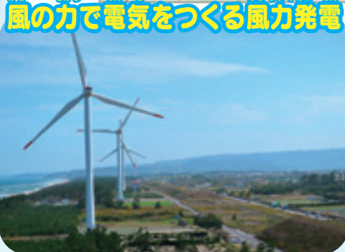
北条町・北条砂丘風力発電所
