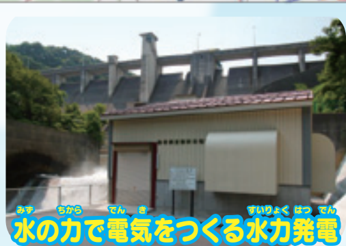
鳥取県企業局・賀祥発電所
