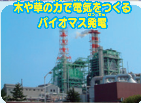
王子製紙株式会社米子工場第一発電所
