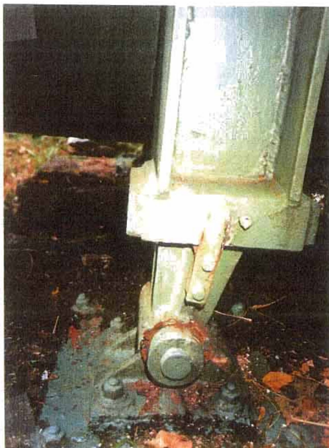
No. 5 左側ロッカー支承
