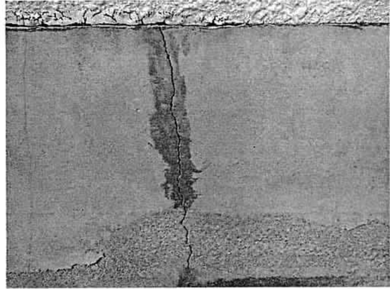
配電盤室屋上補修部分
