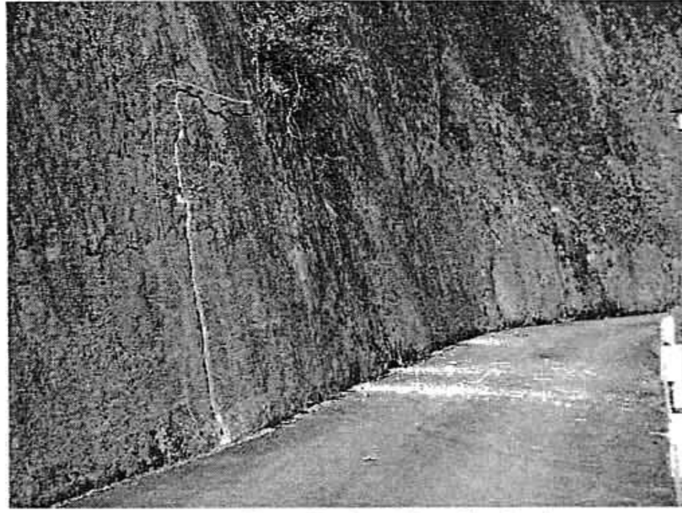
日野川第一発電所進入路壁面
