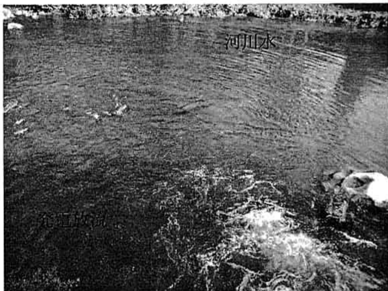
試運転時濁水状況放水ゲート直下
