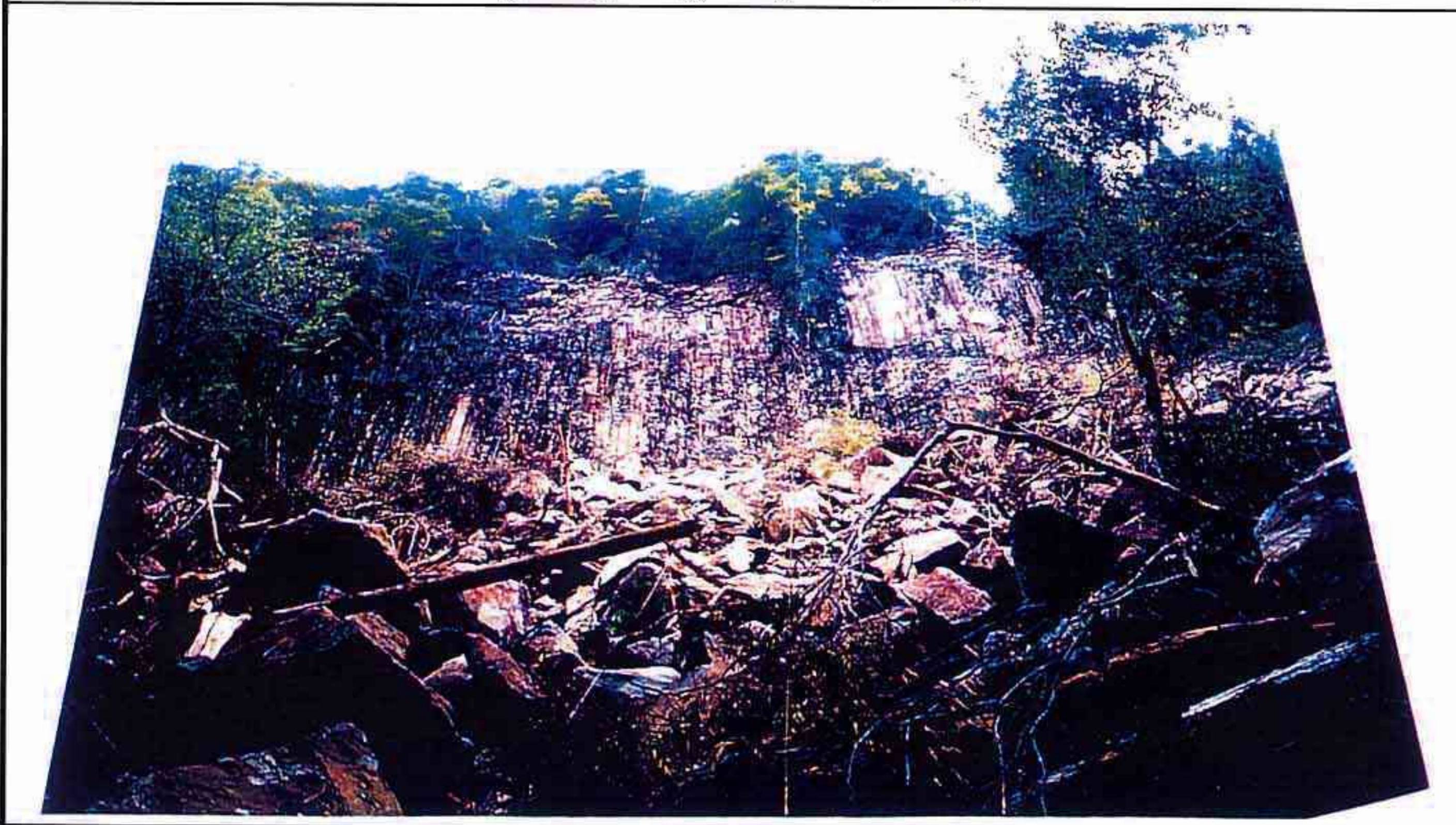
被災状況写真
