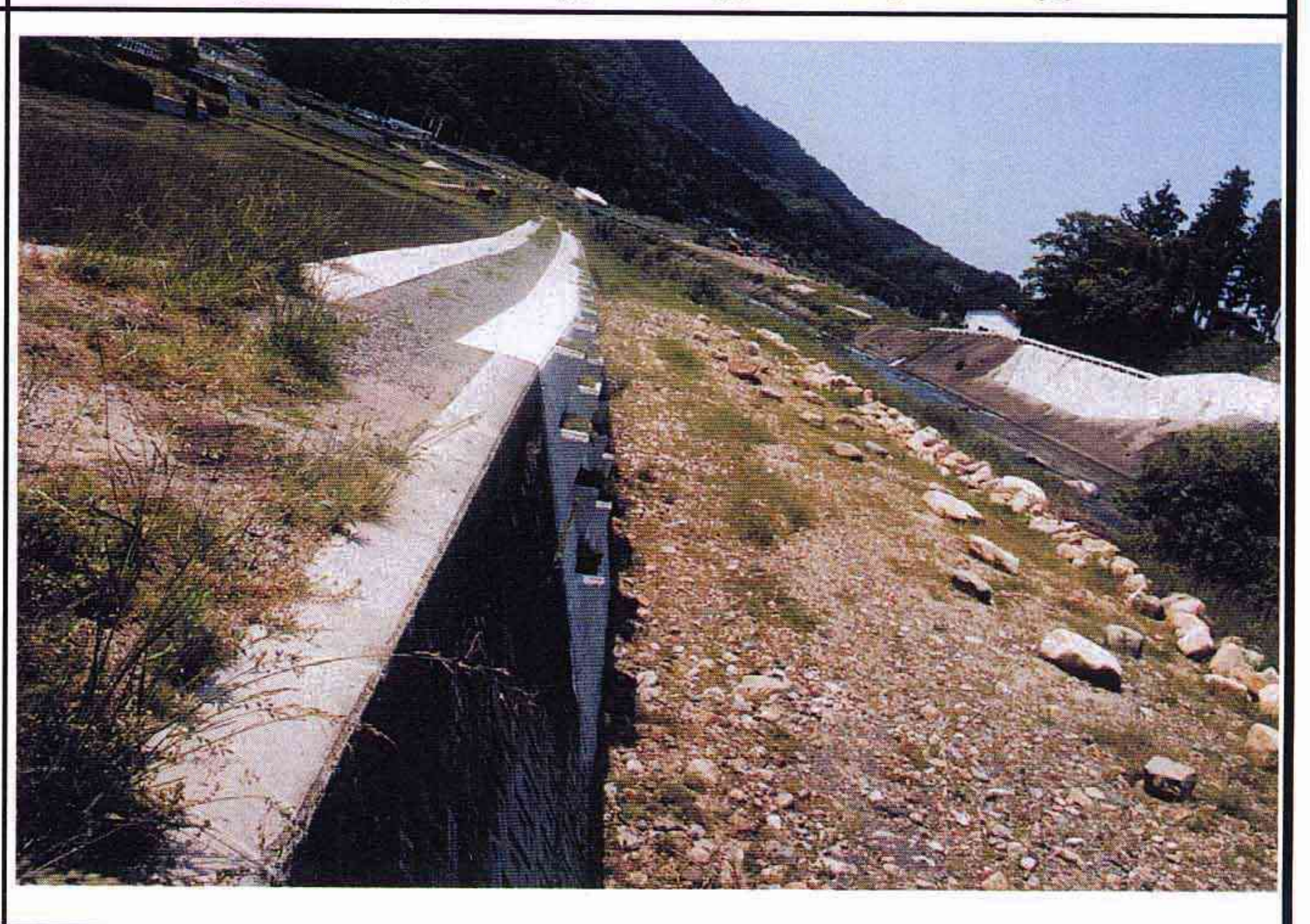
復旧状況写真
