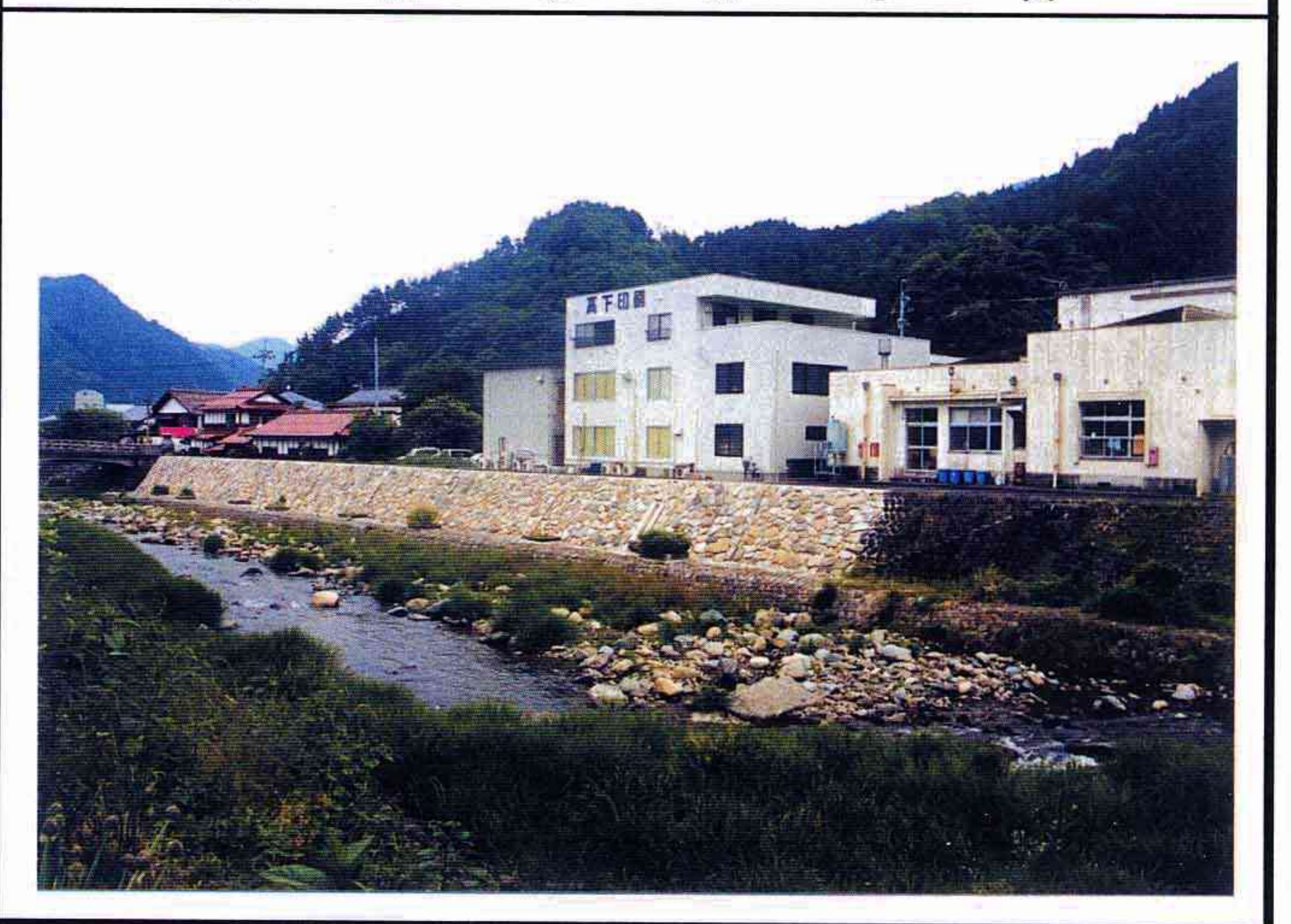
復旧状況写真
