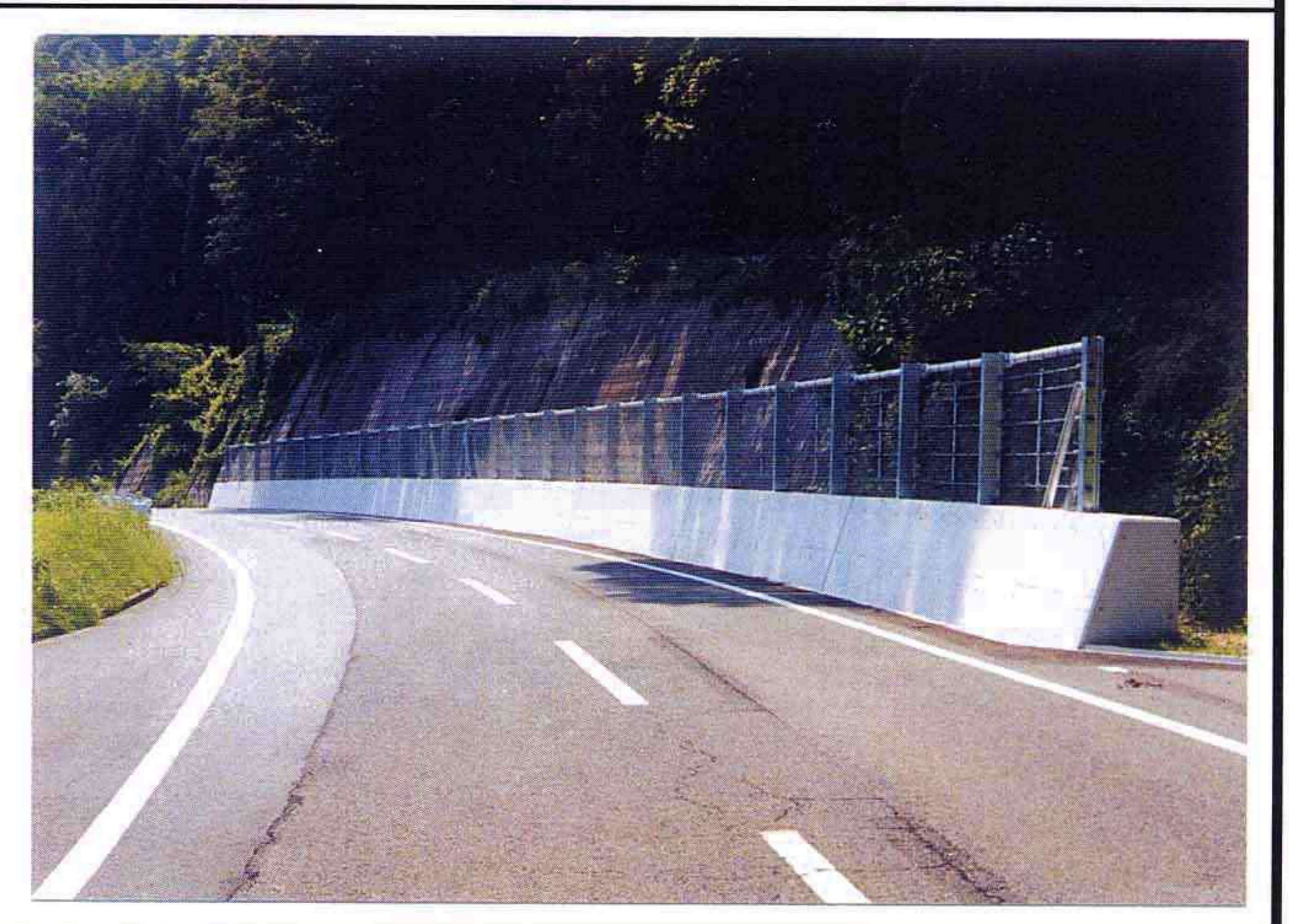
復旧状況写真
