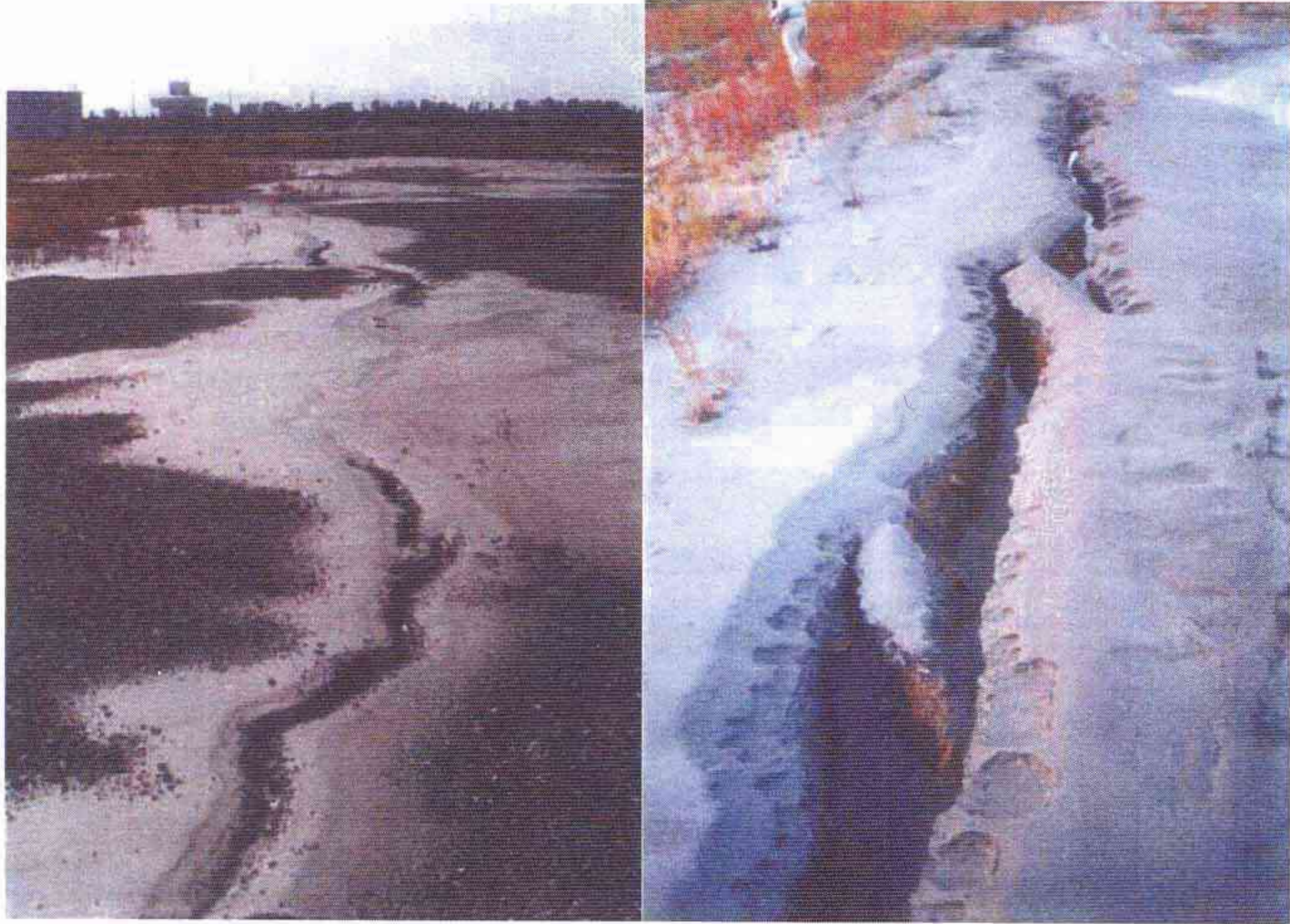
開口クラックに見られる噴砂
