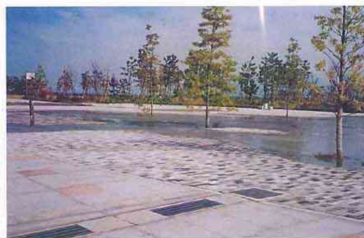
夢みなと公園（広場の液状化）
