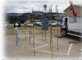
小型移動式クレーン技能講習
