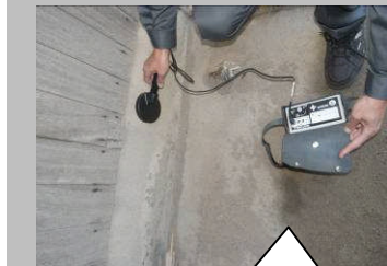
鉄筋探査機による基礎鉄筋の有無の調査
