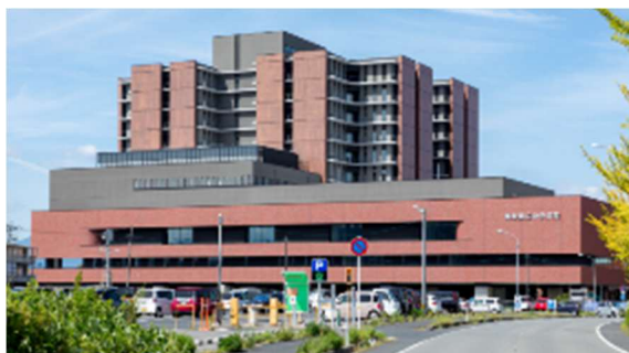
新病院の全景
