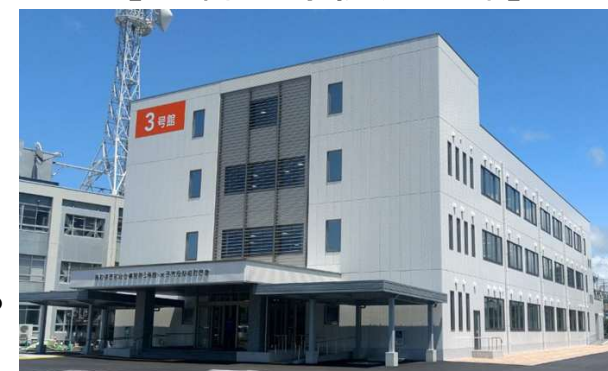
【西部総合事務所3号館】
