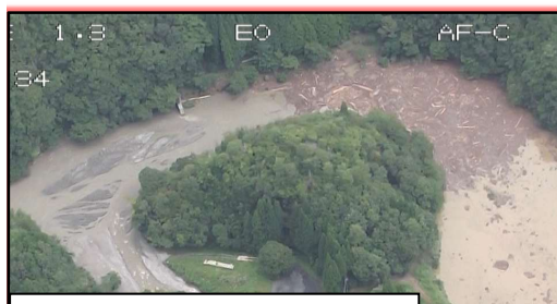
佐治川ダム(土砂・流木)
