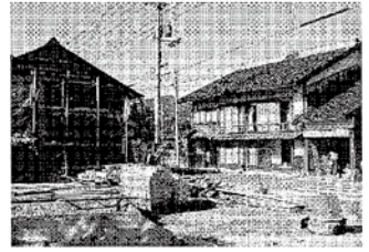
住宅復興が進む日野町黒坂地区
