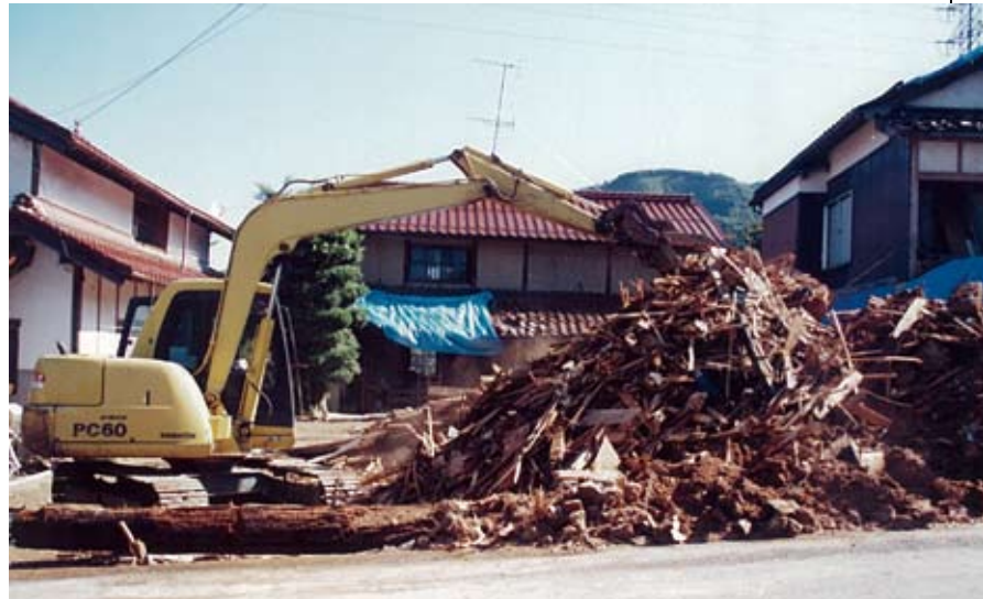
取り壊される被災住宅
