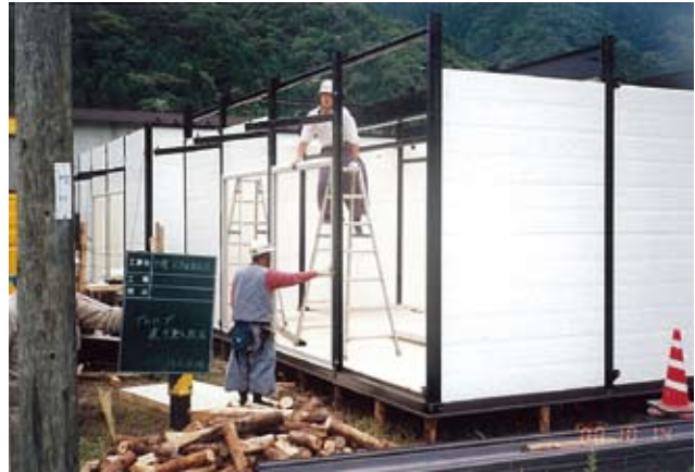
建設中の仮設住宅
