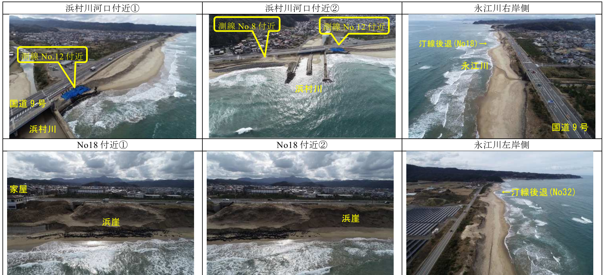
図 1.7.7 気高海岸の海岸侵食状況（撮影：令和 2 年 1 月 17 日）
