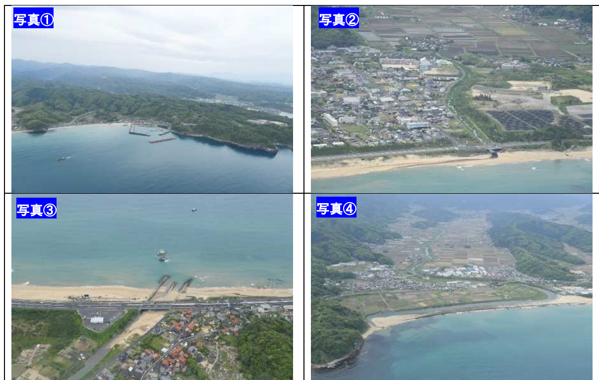
図 1.7.1 気高海岸の航空写真（上図：2018年撮影）と斜め写真（下図：2021年5月撮影）
