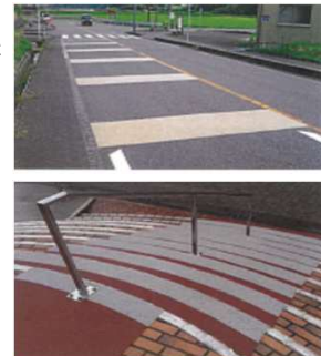
活用: 鳥取県建設技術センター
