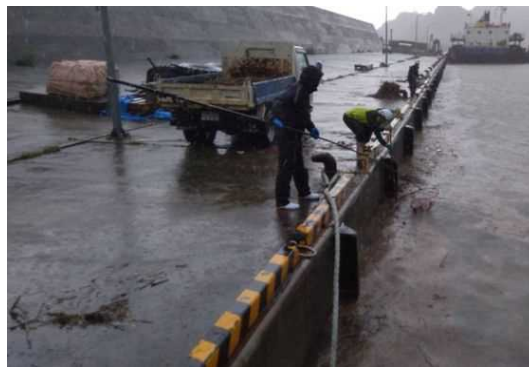
撤去作業状況
