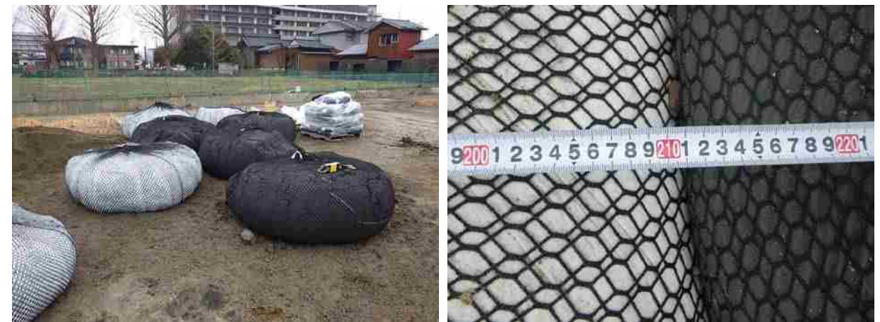
図 5-8 袋詰砂工の設置・施工状況の例
