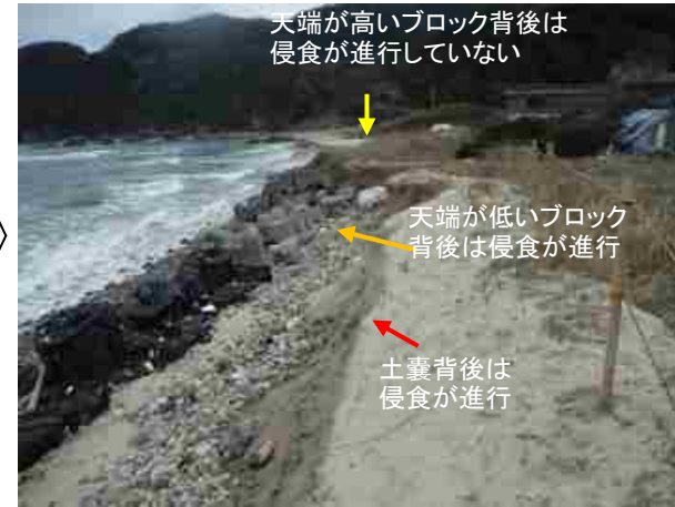
図 2-8 消波(被覆)ブロックと大型土嚢の背後の侵食状況（アングル②）
