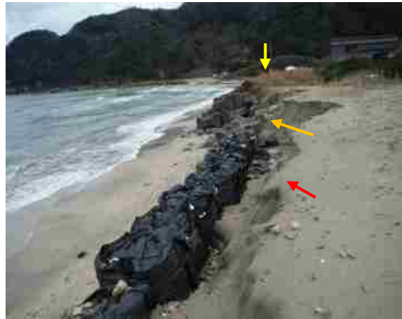
図 2-8 消波(被覆)ブロックと大型土嚢の背後の侵食状況（アングル②）
