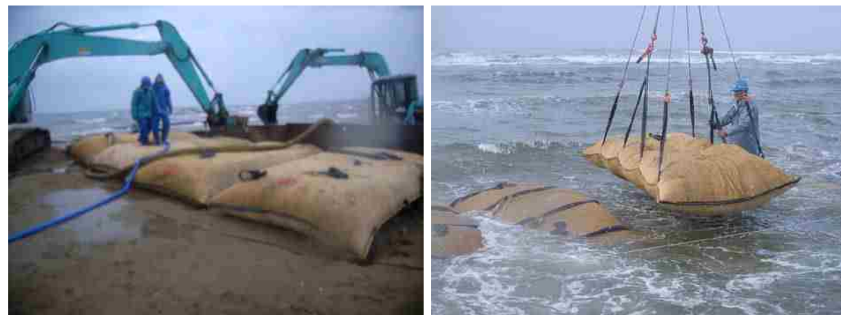
図 5-6 ミニサンドパックの設置・施工状況の例
