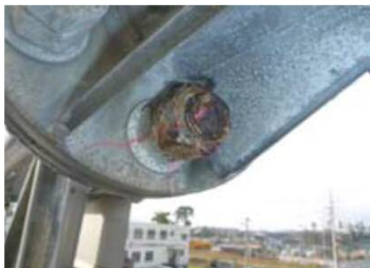
【横梁（標識板取付部）：腐食、健全性Ⅲ】
