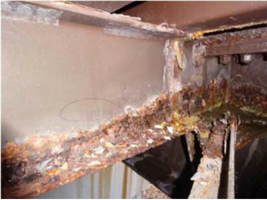
【横梁：腐食、健全性Ⅲ】
