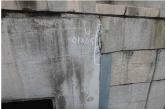
【翼壁部（ウイング）：うき、健全性Ⅲ】
