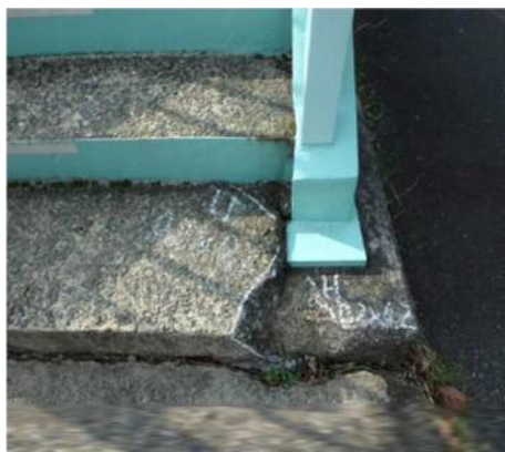
【下部工（橋台）：うき、健全性Ⅲ】
