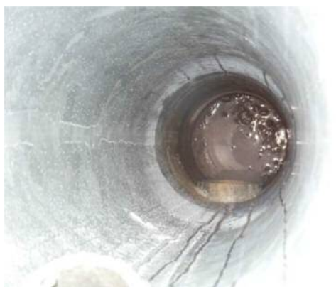
【支柱内部：滞水、健全性Ⅱ】
