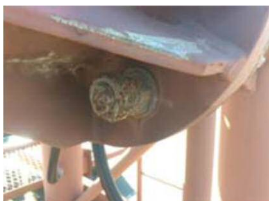
【横梁取付部：腐食、健全性Ⅱ】
