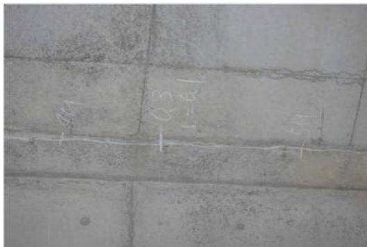
【本体工（頂版）：ひび割れ、健全性Ⅱ】
