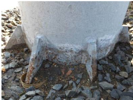
【支柱基礎：腐食、健全性Ⅲ】
