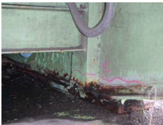
【上部工（主桁）：腐食、健全性Ⅲ】
