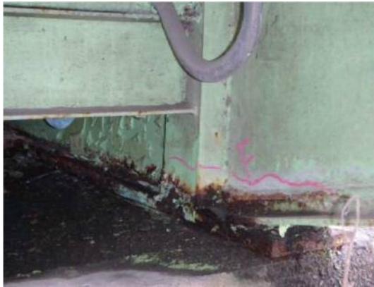
【上部工（主桁）：腐食、健全性Ⅲ】
