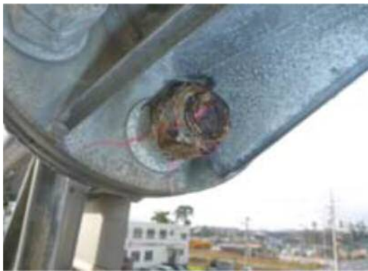
【横梁（標識板取付部）：腐食、健全性Ⅲ】
