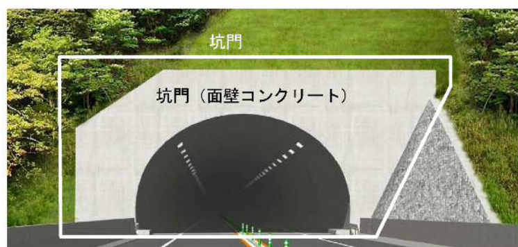
図4.1 トンネル本体工点検箇所
