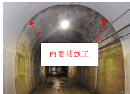
写真2.2 内巻補強工の事例
