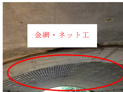
写真2.3 金網・ネット工の事例
