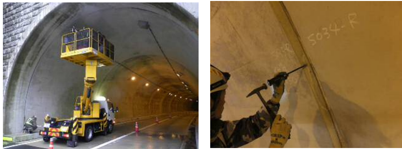
写真4.1 定期点検状況
