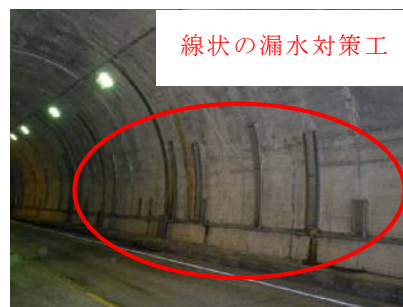
写真2.4 線状の漏水対策工の事例
