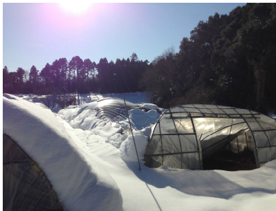
倒壊した花壇苗用ハウス(北栄町)
