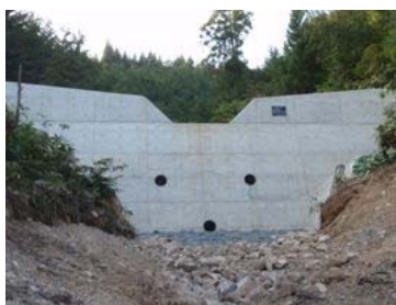
治山ダム（谷止工） （江府町 久連地区）
