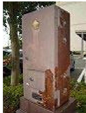
交通信号機（制御機） の老朽化状況
