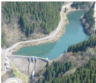
ダム〔ダム・貯水池〕 (春米発電所)
