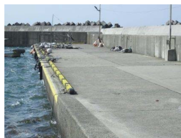
係留施設 物揚場（赤碕港）
