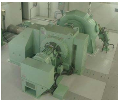
機械〔発電機〕 (袋川発電所)
