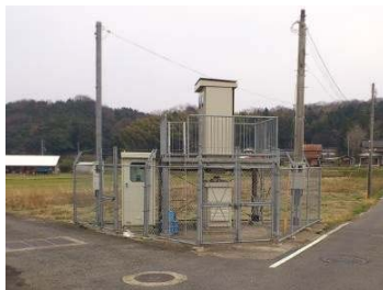
中継ポンプ場 (若土ポンプ場)
