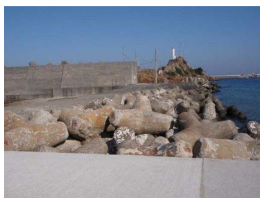
外郭施設 防波堤（鳥取港）
