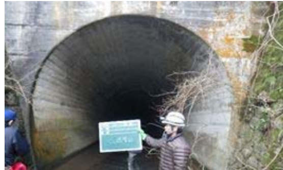
長瀬川トンネル（L=261m）
