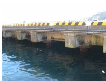
係留施設 岸壁（田後港）
