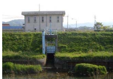
西大路排水機場
