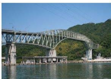
橋梁 (国道 431 号 境水道大橋)
