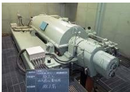
イニシャルコストだけでなくランニングコストも安価な汚泥濃縮機への更新 (平成 26 年度)
