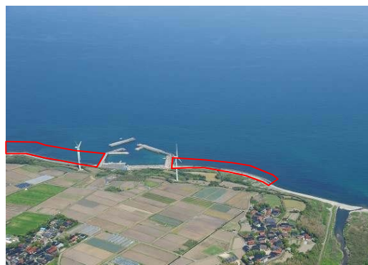
逢坂港海岸（逢坂東・逢坂西地区）
