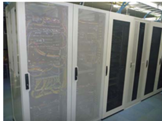
通信機器収容ラック全景（NOC内）
