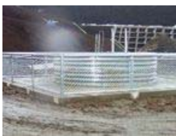
集水井工 （智頭町 大呂地区）
