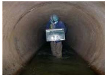
管路 (幹線管渠)
