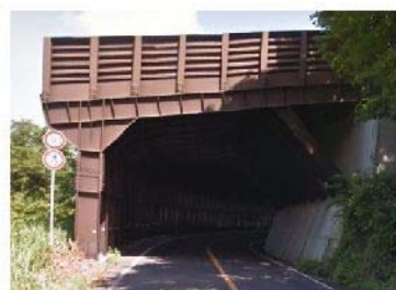
トンネル (倉吉江府溝口線 大内ロックシェッド)
