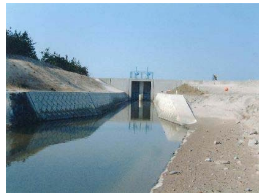
海岸保全施設 日光地区（鳥取市）
