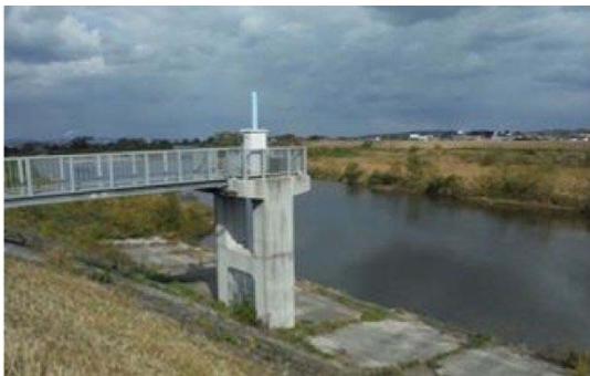
取水施設 [取水施設] (日野工水)
