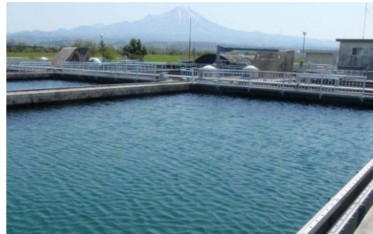
浄水場 [浄水施設] (日野工水)
