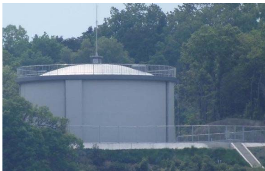
配水池 [配水施設] (鳥取工水)
