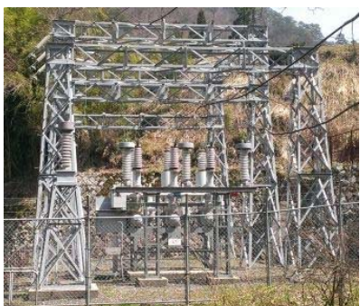
電線路〔送電設備〕 (小鹿第一発電所)
