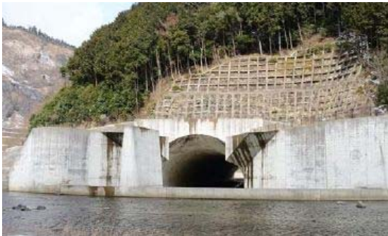
市瀬トンネル（L=230m）
