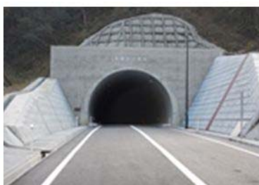
トンネル (日野溝口線 矢倉トンネル)
