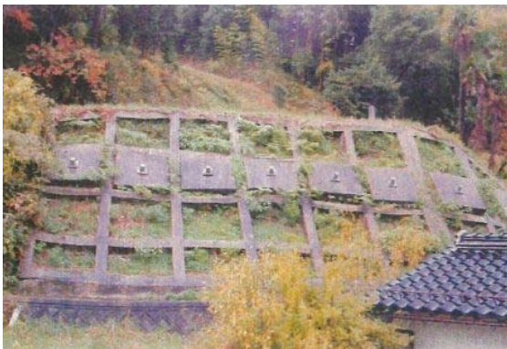
地すべり防止施設 焼杉地区（伯耆町）
