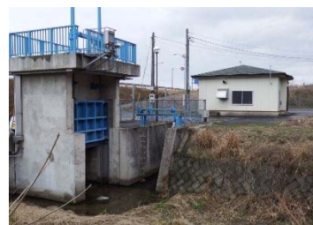
倉田排水機場
