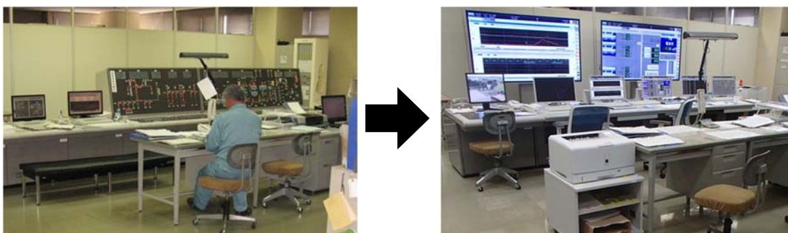
中央監視制御設備の改築（更新）状況
