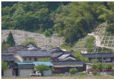
砂防えん堤 (大滝谷川、鳥取市)
