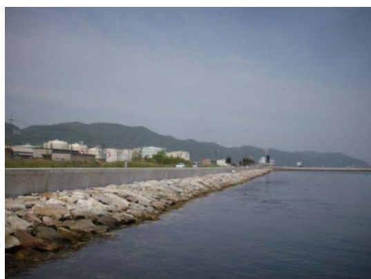
昭和南地区東側護岸
