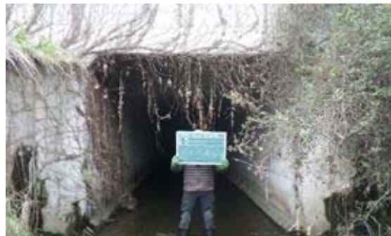
逆川トンネル（L=198m）
