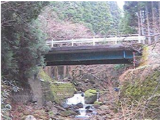
林道橋梁 坂ノ元線 1号基 (智頭町)
