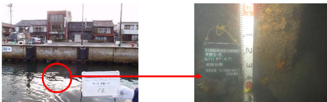
定期点検の状況
