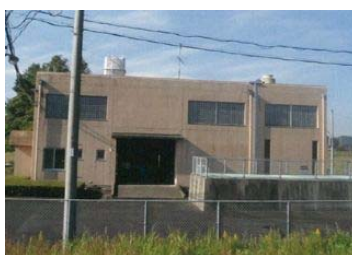
清水川排水機場
