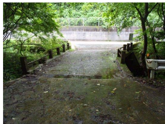
林道橋梁 内井谷線 1号基 (日野町)
