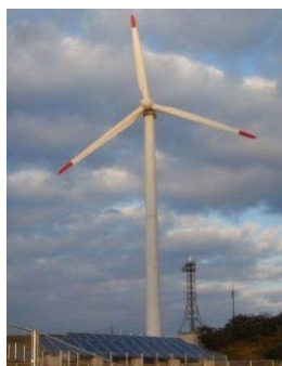
風車〔風車〕 (鳥取放牧場風力発電所)
