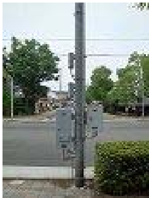
交通信号機 （制御機）
