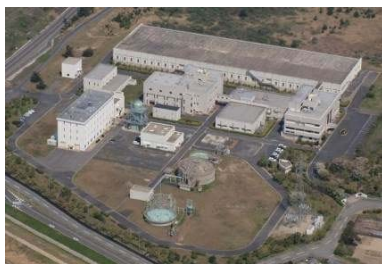
終末処理場 (天神浄化センター)
