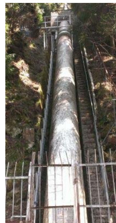
水路〔水圧鉄管〕 (春米発電所)
