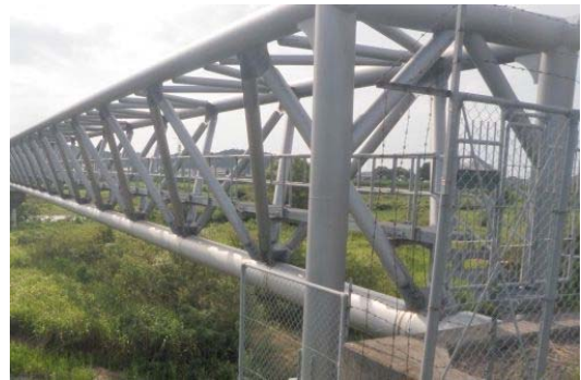
水管橋 [配水管] (鳥取工水)
