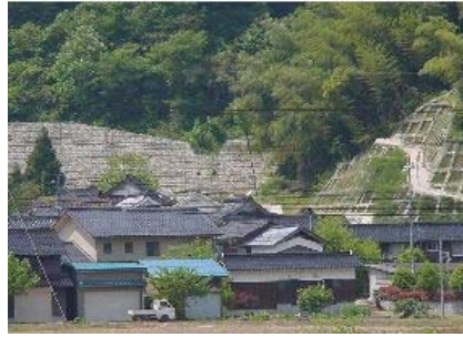
砂防えん堤（大滝谷川）
