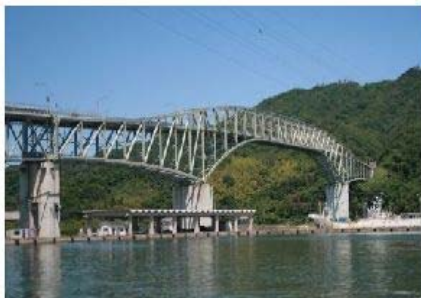
橋りょう（国道 431 号 境水道大橋）
