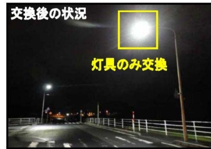
図 6.8 LED 交換後の状況 出典：鳥取県県土整備部資料
