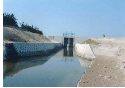
海岸保全施設（日光地区）
