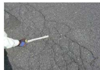
▲ 舗装のひび割れ
