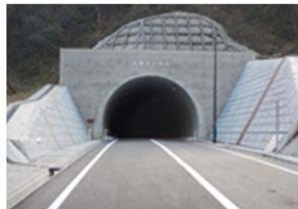
トンネル（日野溝口線 矢倉トンネル）
