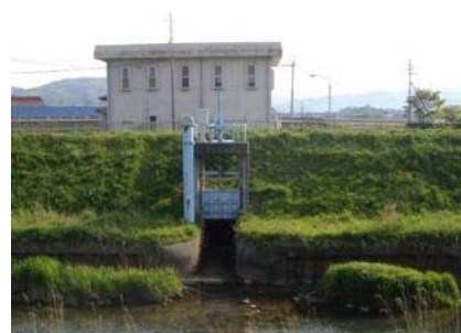
排水機場（西大路排水機場）
