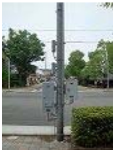
交通信号機（制御機）
