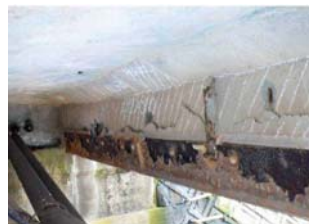
▲ 主桁の損傷状況
