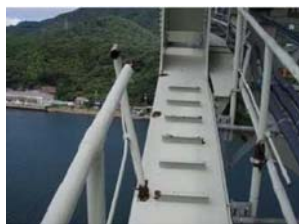
▲ 監査路の腐食・破断状況
