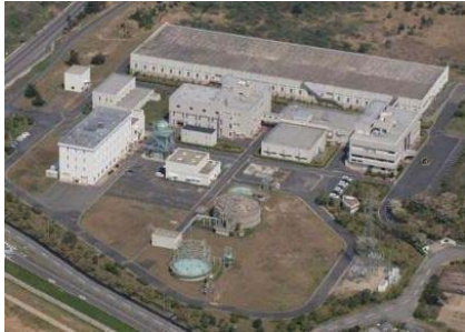
終末処理場（天神浄化センター）
