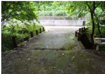
橋りょう（内井谷線 1号基）
