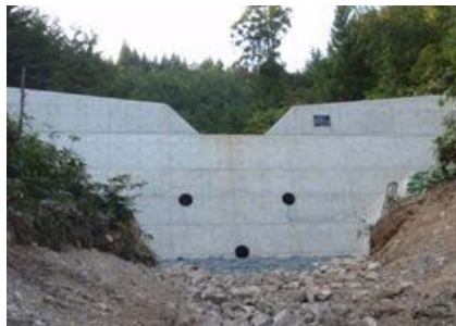
治山ダム（谷止工）（久連地区）
