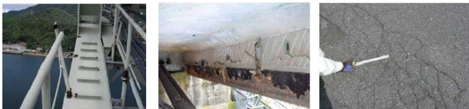
▲ 監査路の腐食・破断状況 ▲ 主桁の損傷状況 ▲ 舗装のひび割れ
