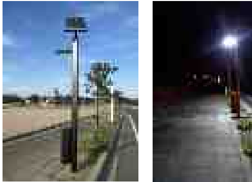
【コナン通りに設置された太陽光蓄電LED街路灯（北栄町）】
